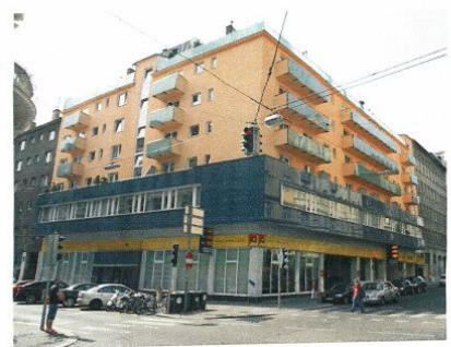
Wohn- und Geschäftshaus Marxergasse 10 Marxergasse 10 A 1030, Wien-Landstraße
