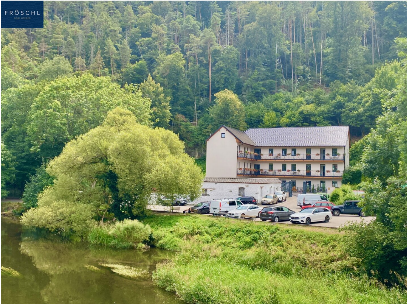
Ansicht von der Thaya-Brücke - Pic 1
