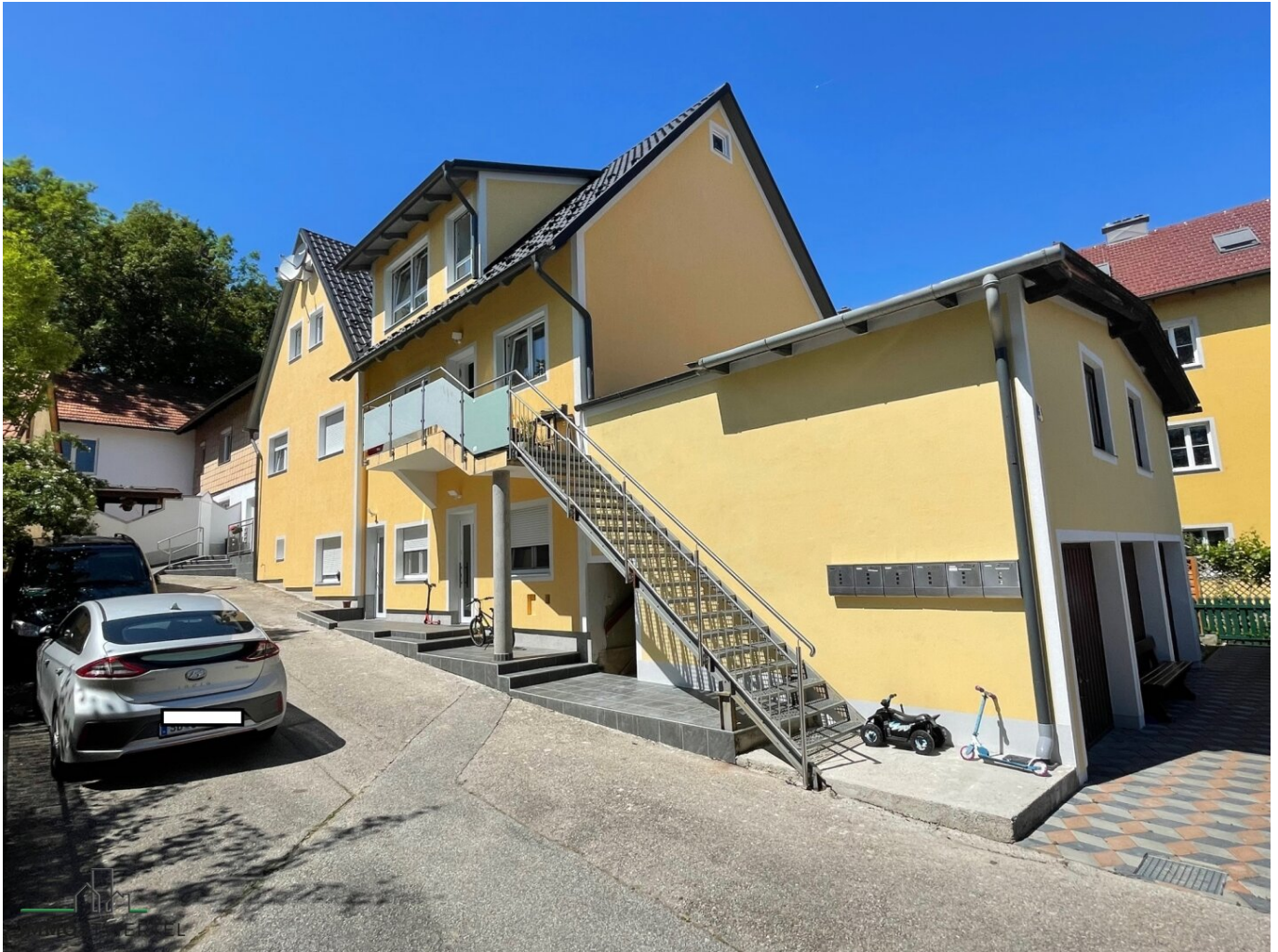
Außenansicht von Augasse
