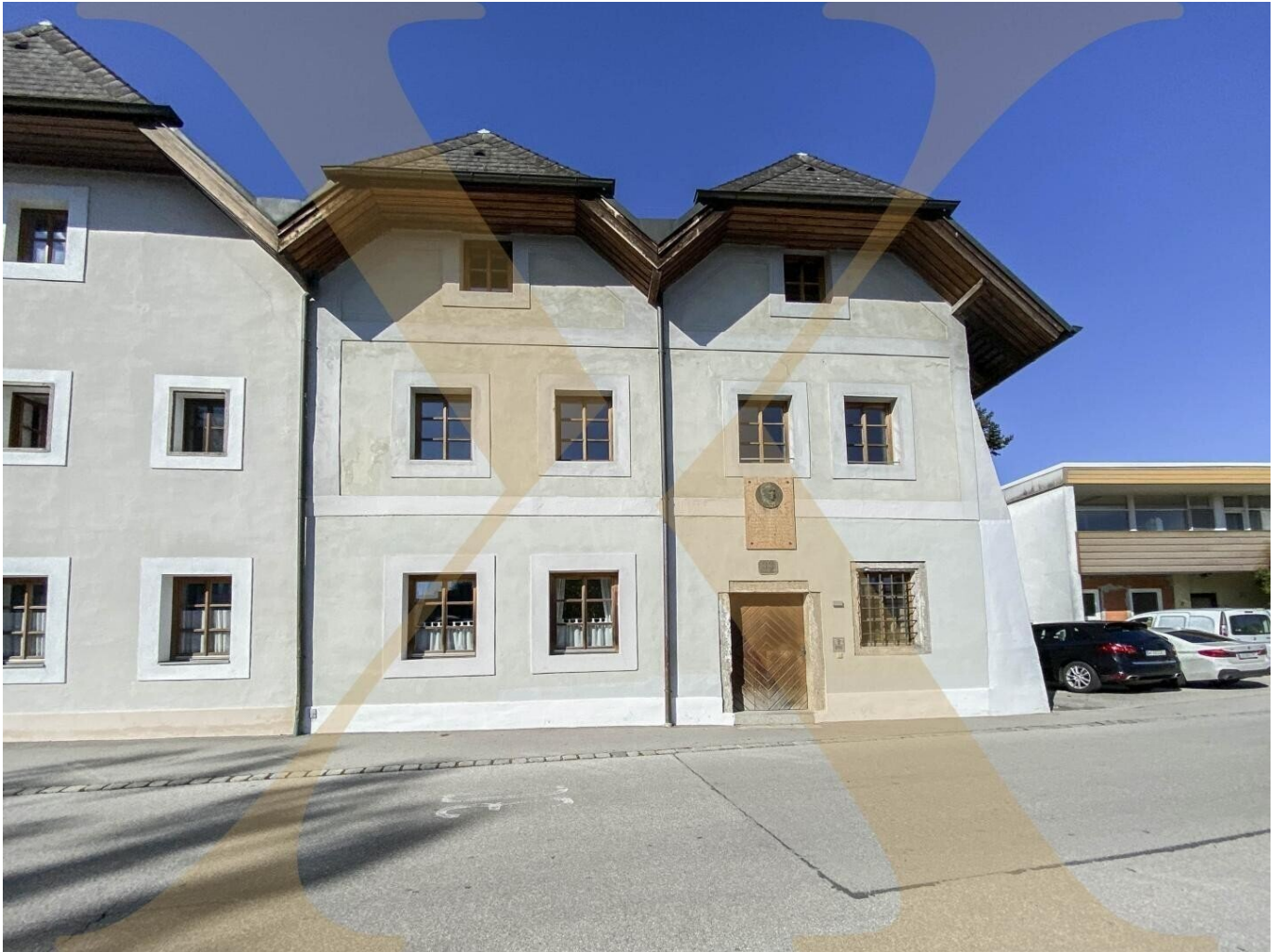
Außenansicht Haus I
