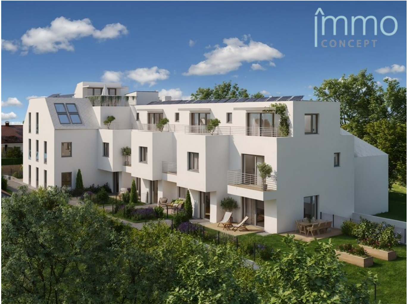
Ansicht Parkgarten Mauer
