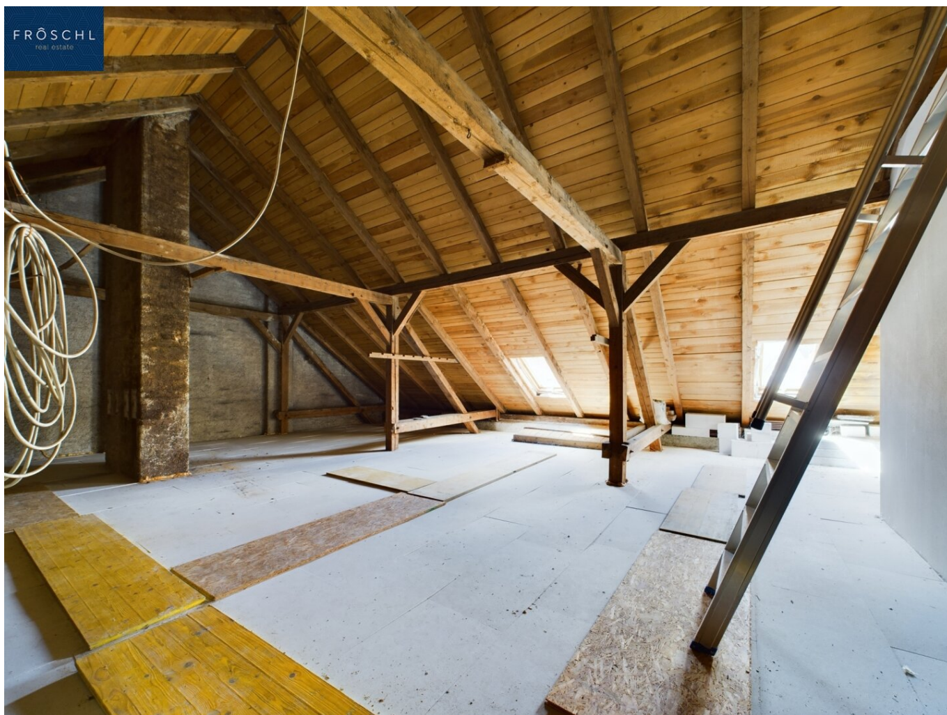
Ansicht Rohdachboden - Pic 2
