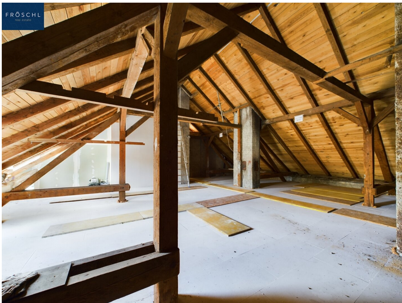
Ansicht Rohdachboden - Pic 1
