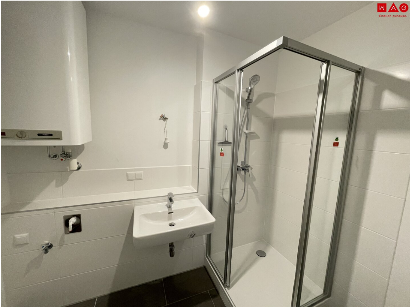
Symbolfoto Bad nach Sanierung
