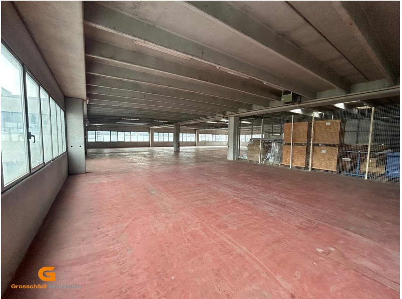
Lager Rückgebäude 1OG
