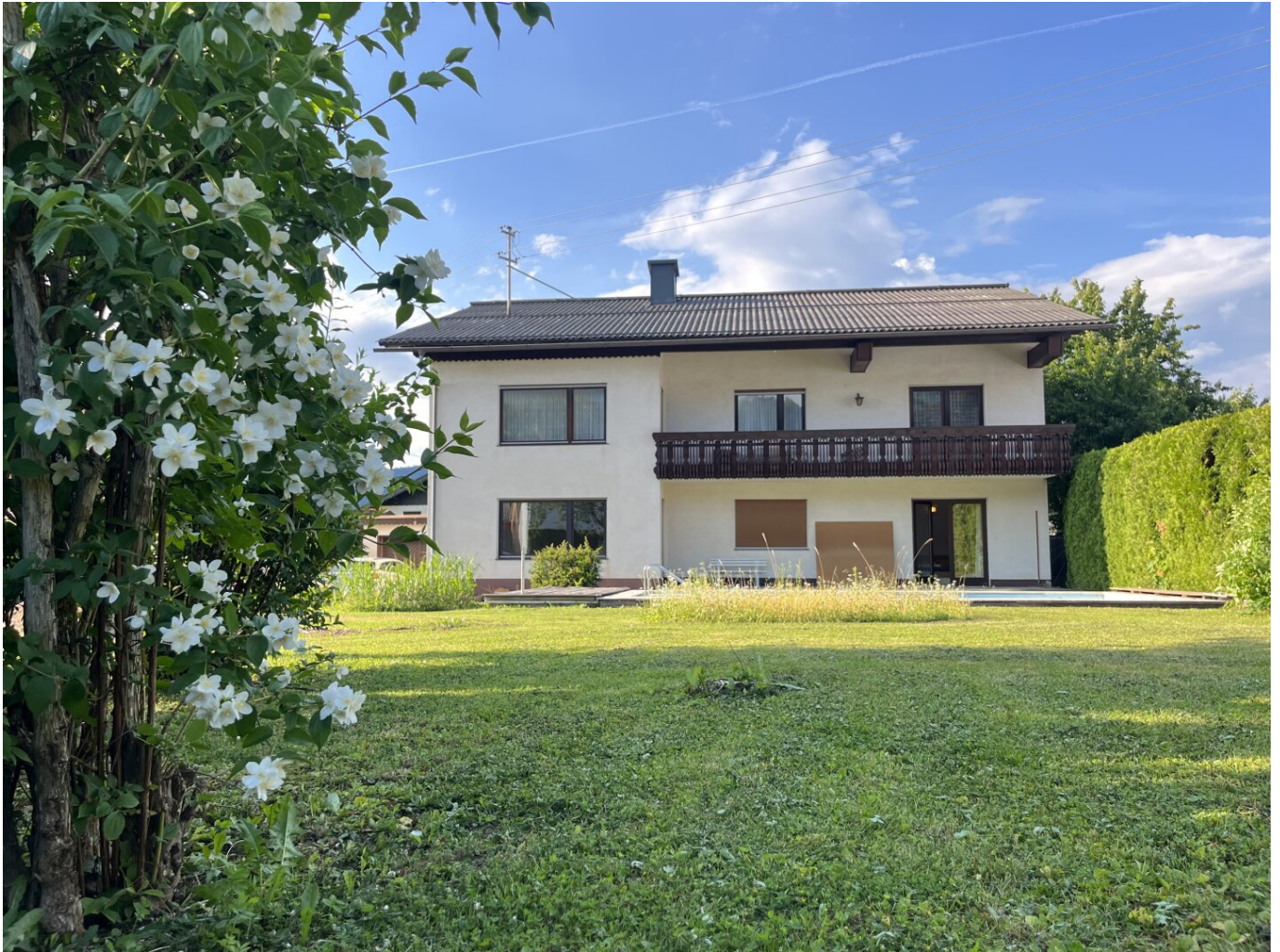
Kompagnon Immobilien Südansicht
