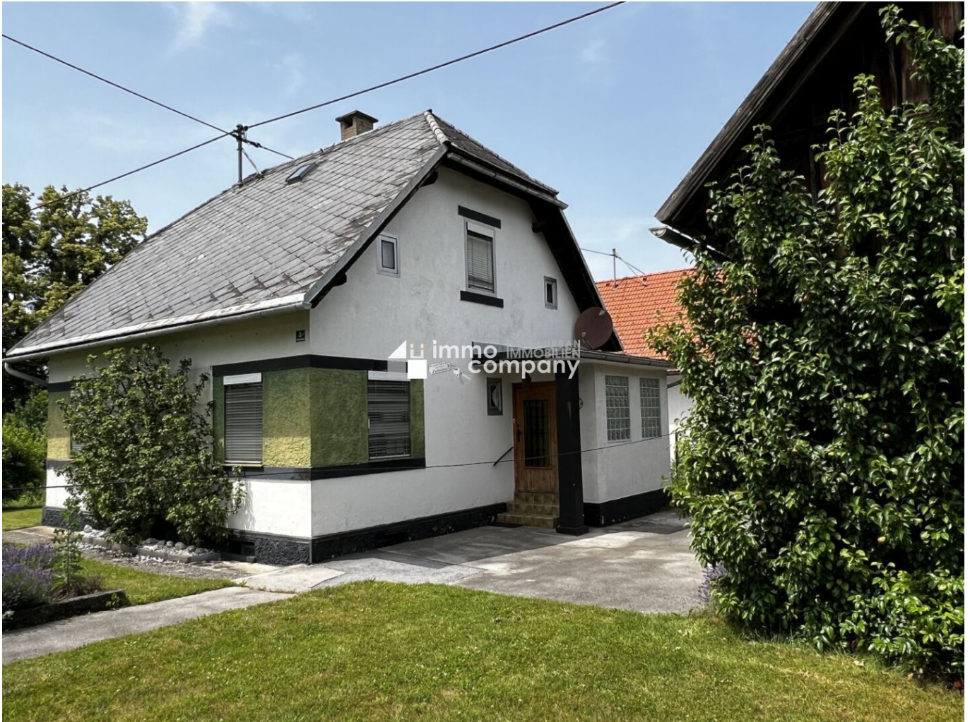
Einfamilienhaus Ferlach - Südostansicht
