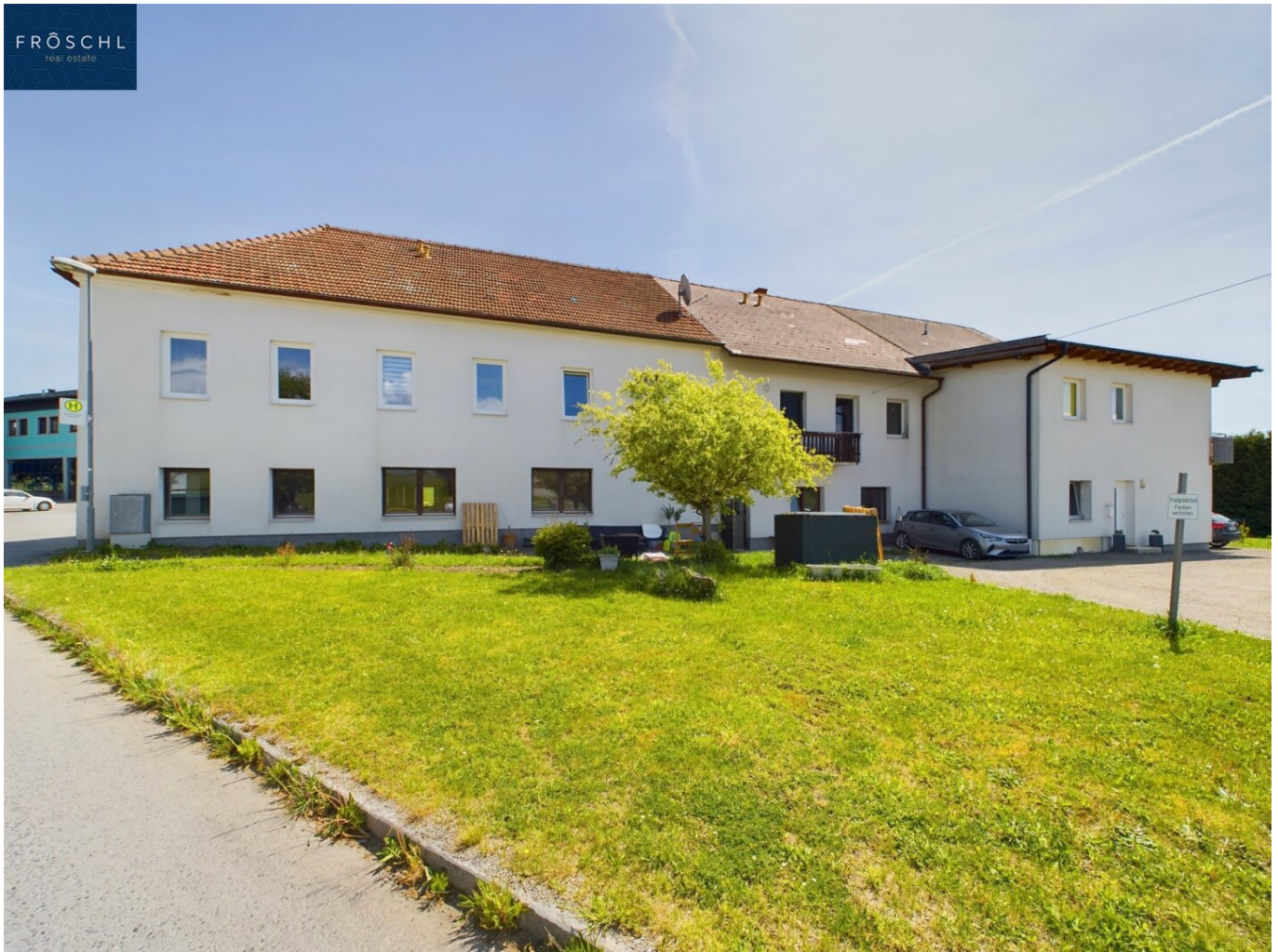
Hausansicht - Straße - Ansicht 2
