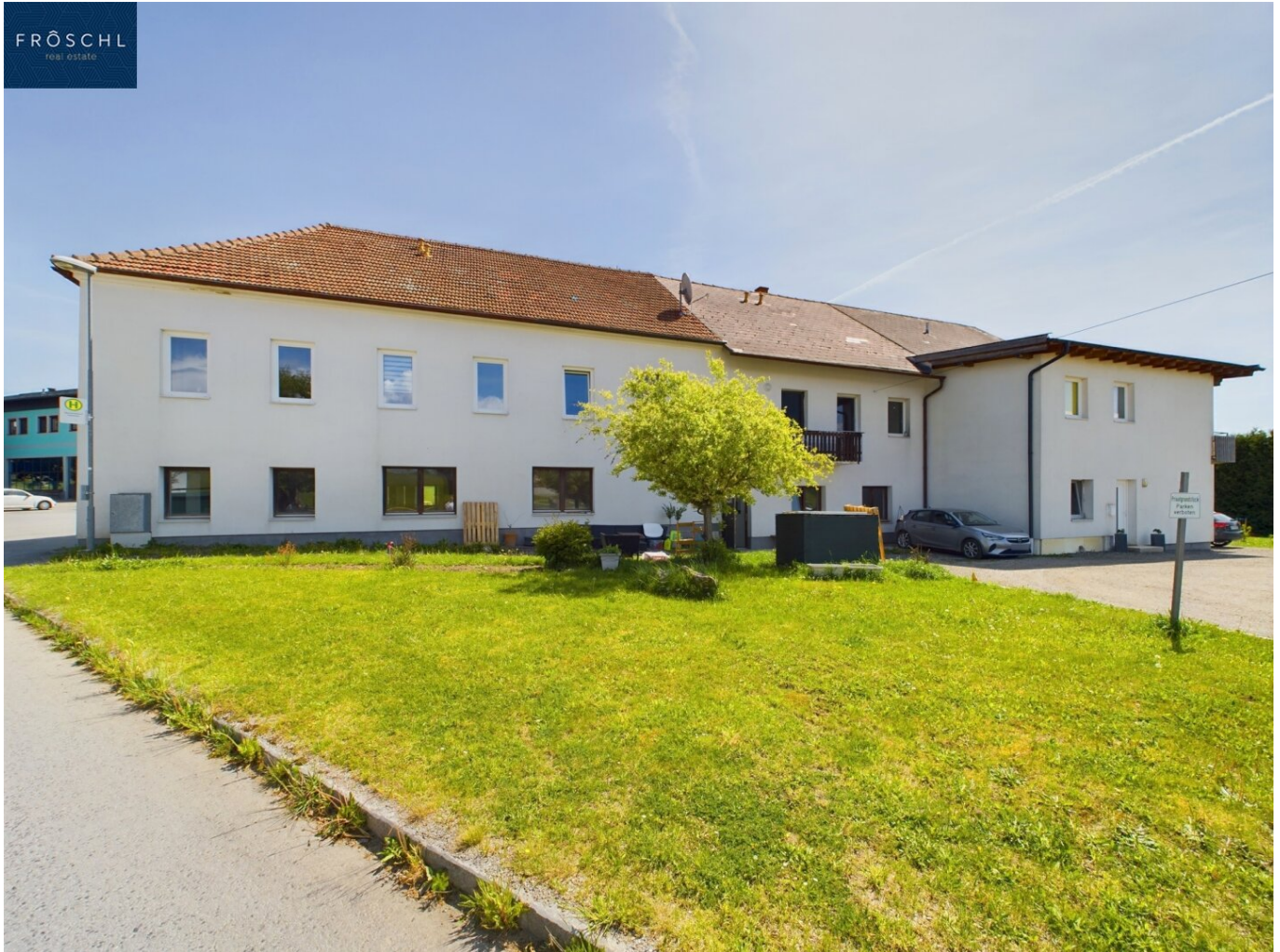
Hausansicht - Straße - Ansicht 2
