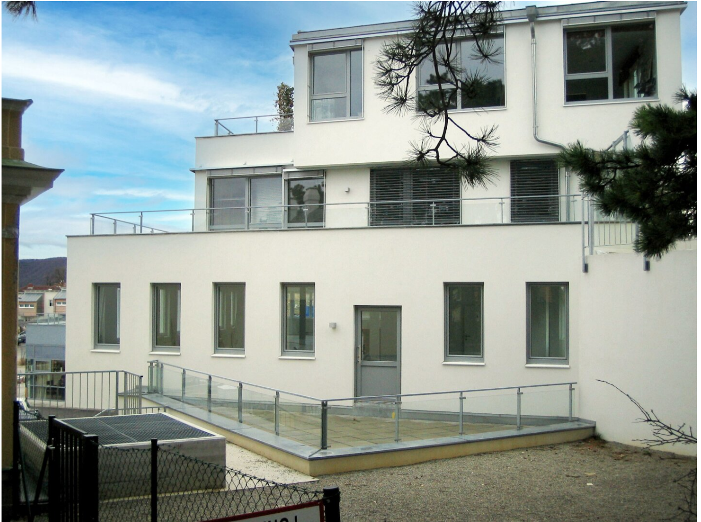
Büro mit Terrasse
