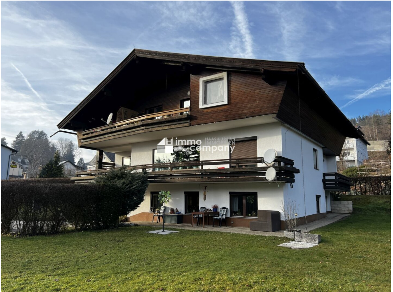
Zinshaus Velden - Südseite
