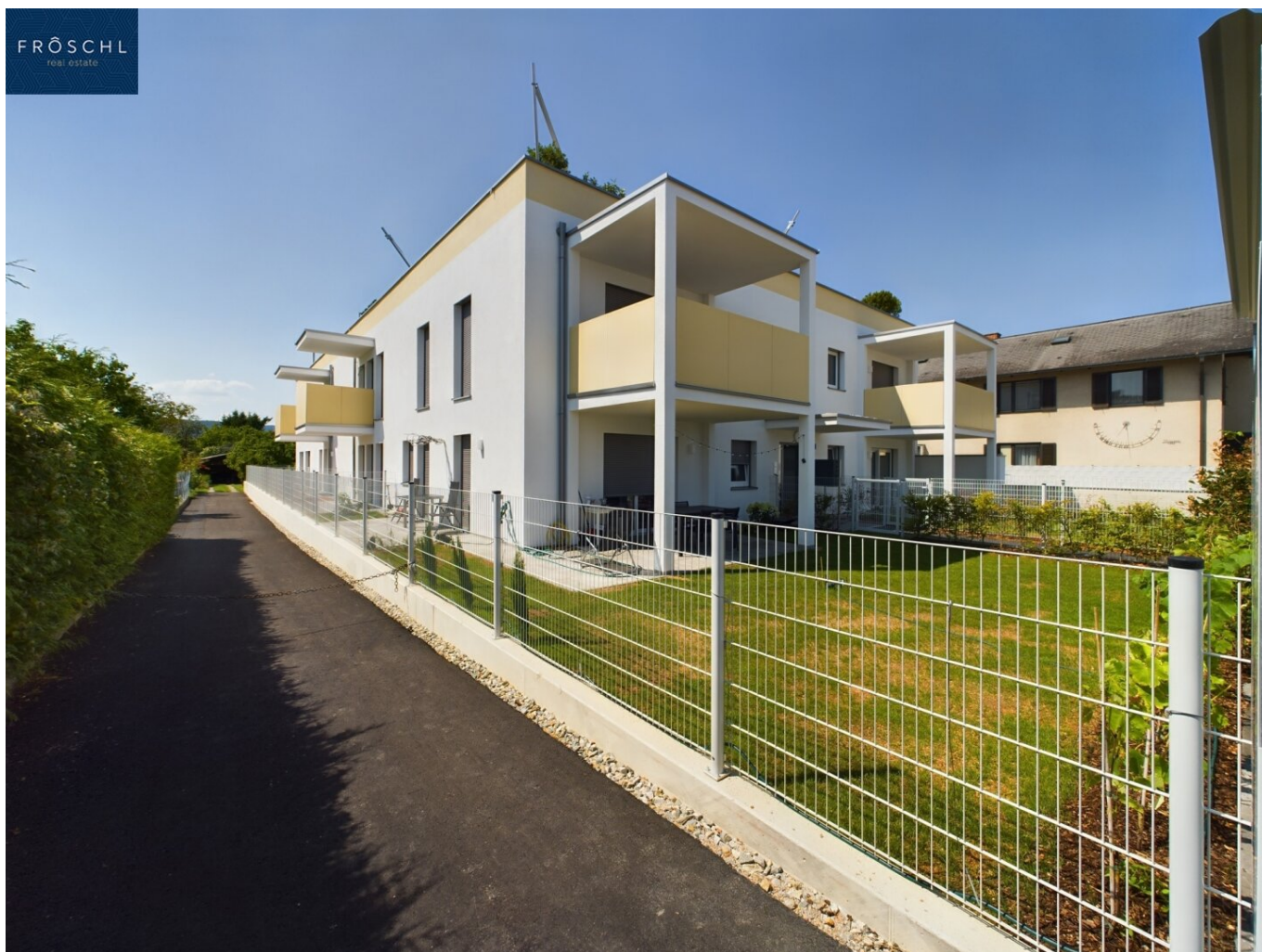
Ansicht der Richtung Nordwesten
