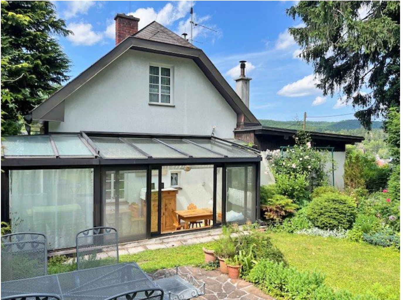
Hausansicht mit Wintergarten gartenseitig
