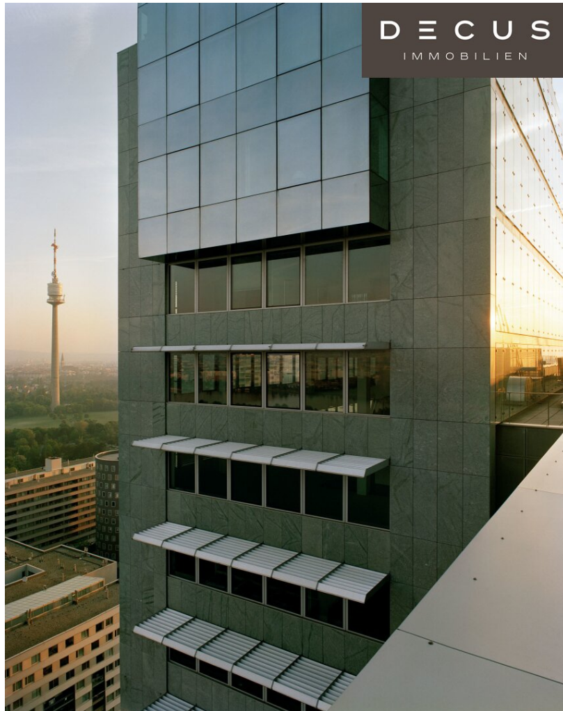
Ares Tower Ansicht
